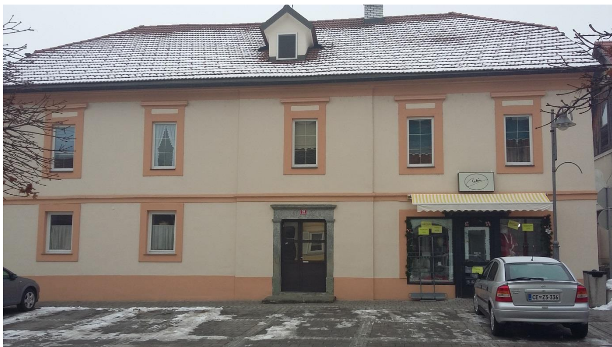
Slika 6: Stavba, v kateri je bila nekoč gostilna Pri Pošti
